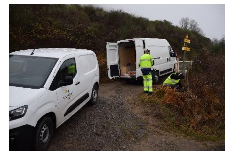
Pose de la nouvelle signalétique de randonnée
