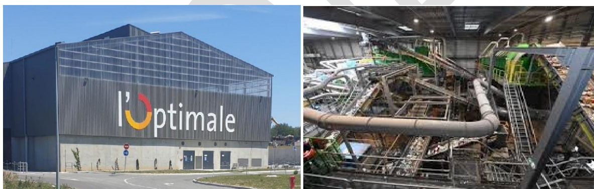
Figure 23 : Installations de traitement l'Optimale (gauche) et TriValLoire (droite)
